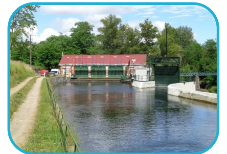
Pictures: © VAW, ETHZ; © Olav König; © Pôle Ecohydraulique de l'AFB
