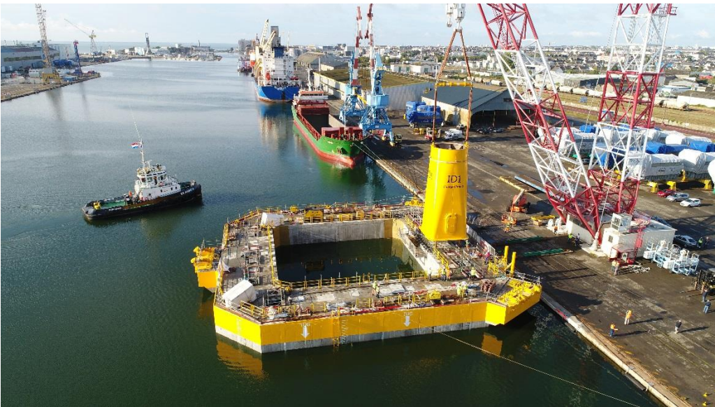
Août 2017 : la pièce de transition est installée
