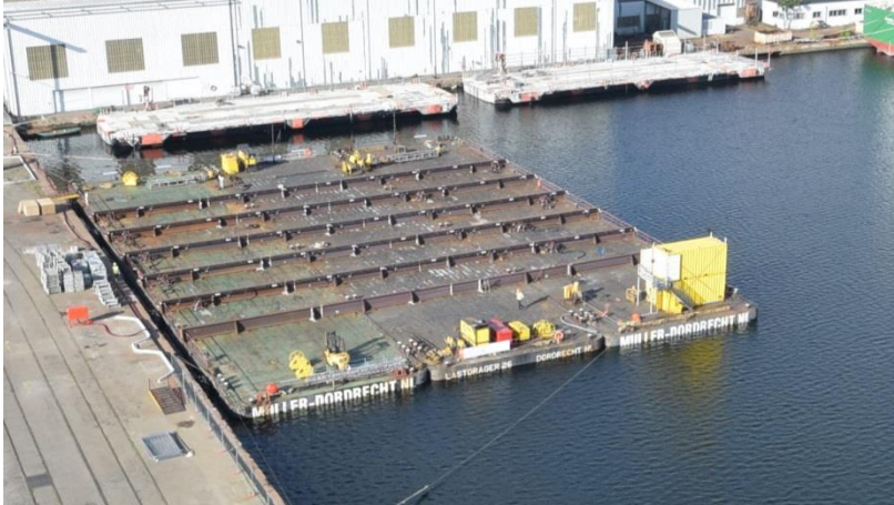
Septembre 2016 : les barges de construction sont en place.
