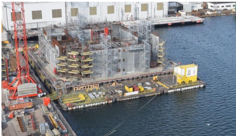
Mars 2017 : 60% du flotteur est construit
